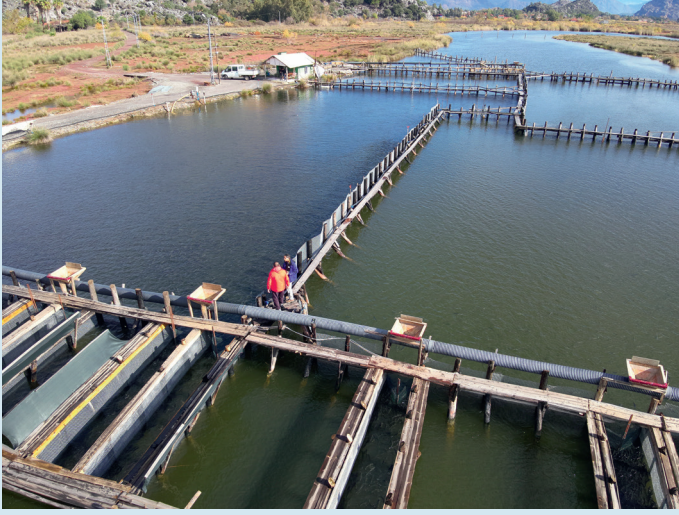
Başta kefal, levrek, çipura ve yılan balığı olmak üzere, Köyceğiz gölünden Ege denizine göç eden ve geri dönen balıkları yakalamak için bir savak sistemi kullanılmaktadır.
