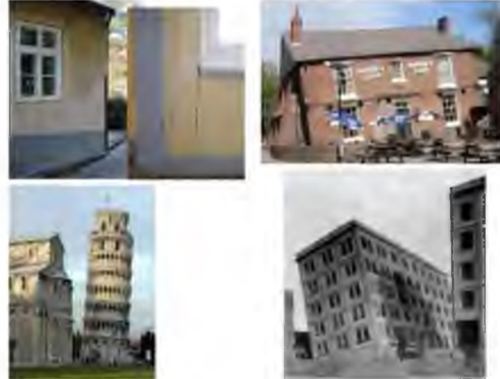
Farklı oturma sonucu hasarı ve yarı yatan yapılar
