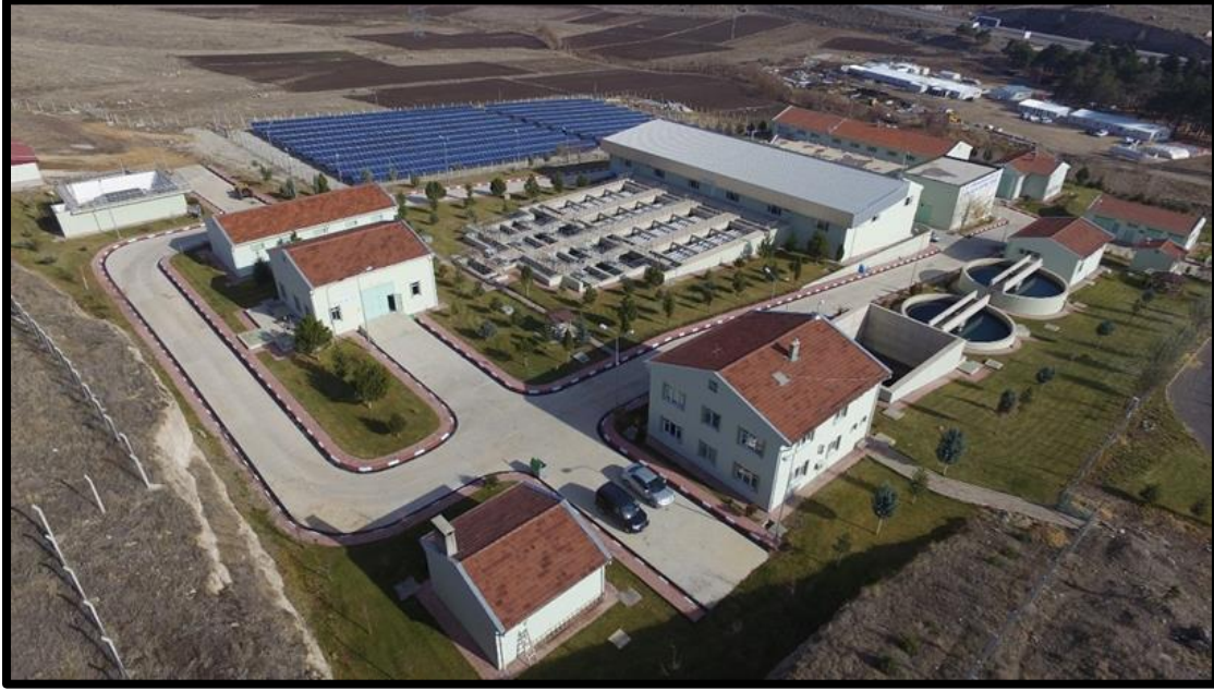
Afyonkarahisar İçme Suyu Arıtma Tesisi
