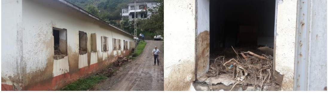
Şekil 1.2 Taşkın sonrası içi rüsubat ile dolup kullanılamaz hale gelmiş bir yapı (Artvin – Hopa, 2015)
