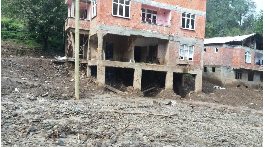
Şekil 1.1 Taşkından zarar gören bina (Artvin – Hopa, 2015)
