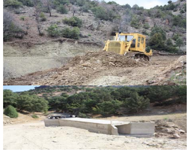
Alt yapı çalışmalarından görünüm (yol yapımı, menfez)
