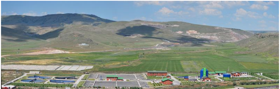
Resim 2. Kayseri İleri Biyolojik Atıksu Arıtma Tesisi
