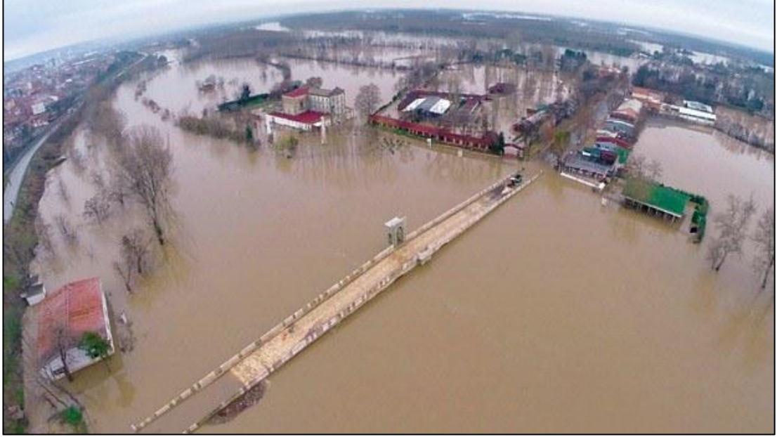
Şekil 17. Karaağaç Mahallesi taşkın görüntüsü
