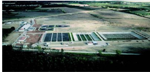
Şekil 35. Tarsus Atıksu Arıtma Tesisi, 43.000 m 3 /gün
