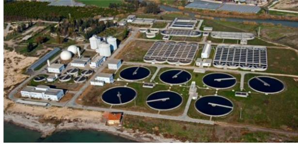
Şekil 34. Karaduvar Atıksu Arıtma Tesisi, 150.000 m 3 /gün
