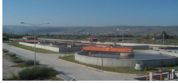
Şekil 36. Silifke Atıksu Arıtma Tesisi, 12.000 m 3 /gün
