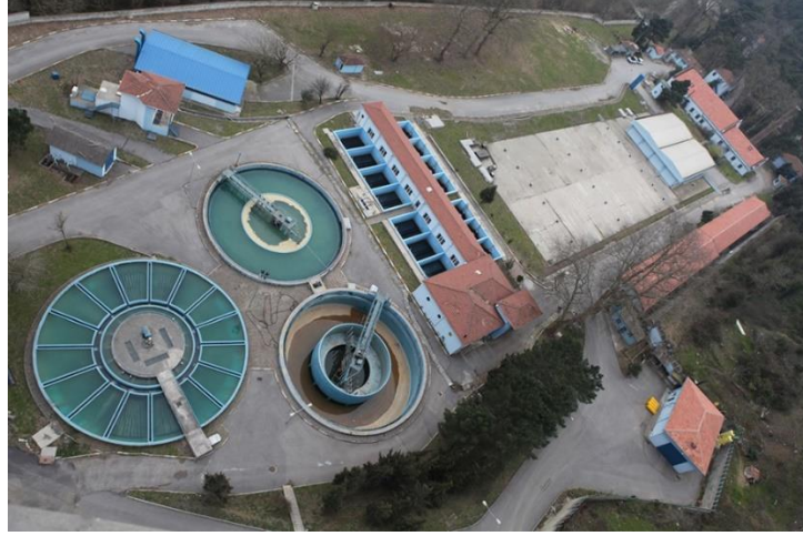
Şekil 17 Elmalı İçme Suyu Arıtma Tesisi (İSKİ 2016b)
